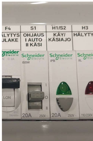
Kuva 6. Ohjauskytkin (S1), käsiajopainike ja vihreä valo (H1/S2)
