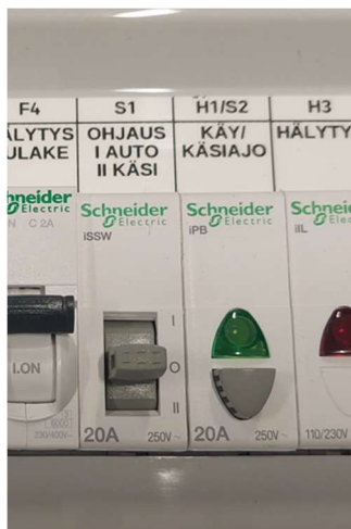
Kuva 6. Ohjauskytkin (S1), käsiajopainike ja vihreä valo (H1/S2)
